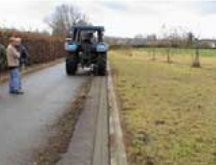
Foto 16. Borstelen met horizontale borstels.
