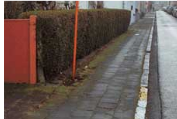
Foto 10. De voegen aan de voet van dit paaltje zijn slecht afdichtend. Bovendien is er een verzakking. Dat zijn allebei omstandigheden die kruidgroei aantrekken.
