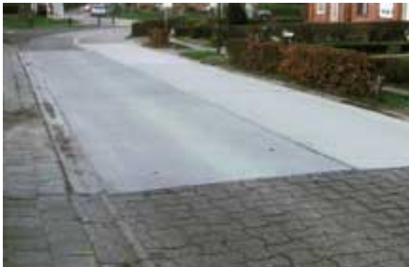
Foto 1. Gesloten verharding: beton en asfalt.
